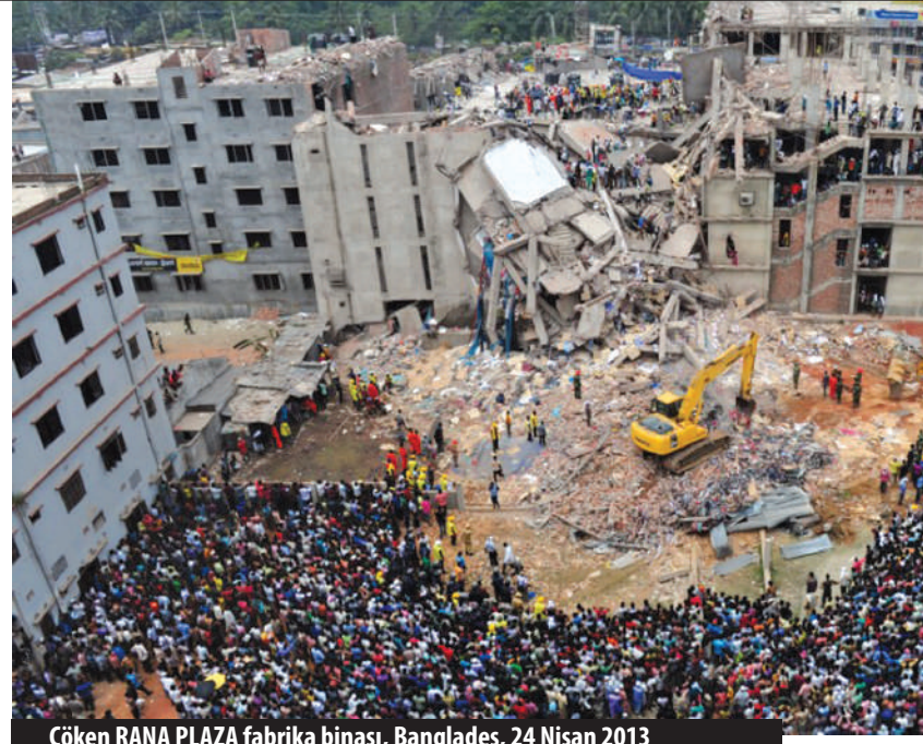
Çöken RANA PLAZA fabrika binası, Bangladeş, 24 Nisan 2013
